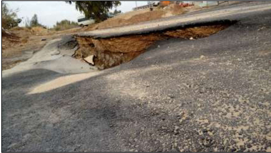
איור 8. שקיעות בקטע אספלט זמני בכביש 3 אשר בוסס ע"ג שכבות מילוי קיים
